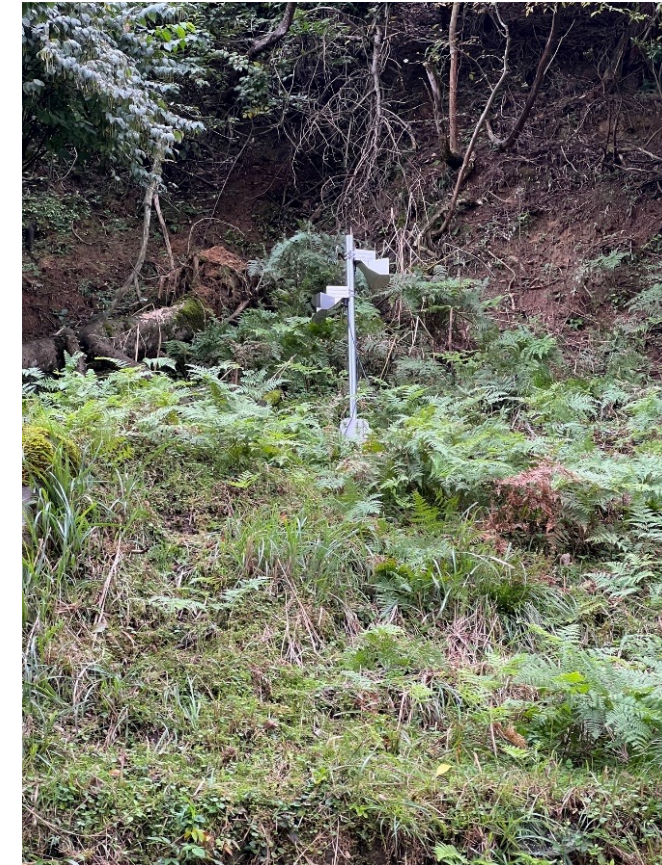
山側に設置している 屋外用スピーカー
